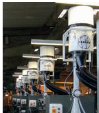
Montaje en el soporte de la máquina
